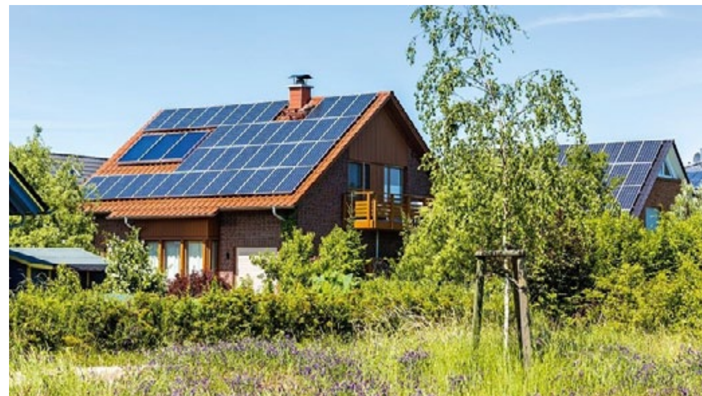
Najkorzystniej, jeśli panele fotowoltaiczne skierowane są na południe i nachylone do poziomu pod kątem zbliżonym do 45°
