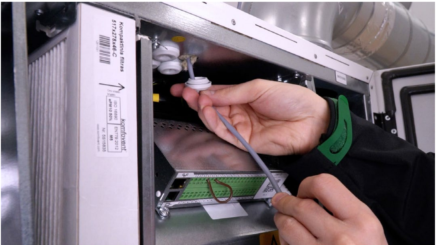
Zabezpiecz przewód od dołu dolną przelotką.
